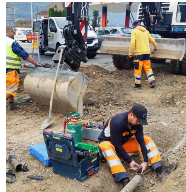
Am Morgen des 24. September beschädigte ein Bagger bei Grabarbeiten auf der Höhe der Autogarage Burkhard ein Netzkabel. Ein zweistündiger Stromausfall war für Teile im Gebiet Bodenacker und Kreuzacker in Laupersdorf die Folge. Der Bagger hatte das Niederspannungskabel praktisch durchtrennt, weshalb mehrere Sicherungen in der KVK Kreuzackerweg durchgebrannt sind. Sogar in der Einspeisestation der TST Bodenacker liess dieser Kurzschluss eine Sicherung durchbrennen.
